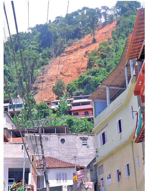
Desmoronamento no Morro da Carioca, no centro de Angra, RJ.
